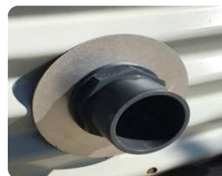
Prostup stěnou nádrže
