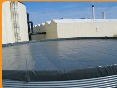
Uzavřený plovoucí kryt s izolační vrstvou
