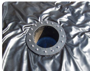
Flansch Bodendurchführung
