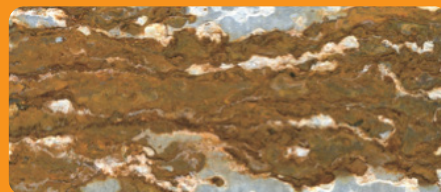
Galvanizarea convențională după 6 săptămâni într-un test de pulverizare cu sare
