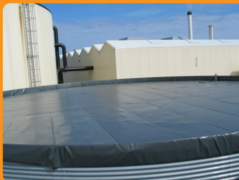
Capac plutitor închis, izolat
