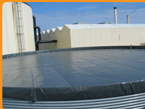
Плавающий герметичный чехол с температурной изоляцией
